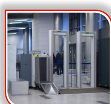
البوابات الأمنية Security Gates
